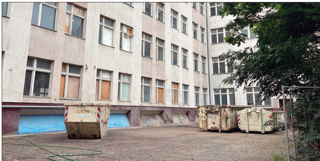
Noch stehen am Maybachufer Container auf dem Hof, doch im kommenden Jahr soll mit dem Bau neuer Wohnungen begonnen werden. Foto: privat
